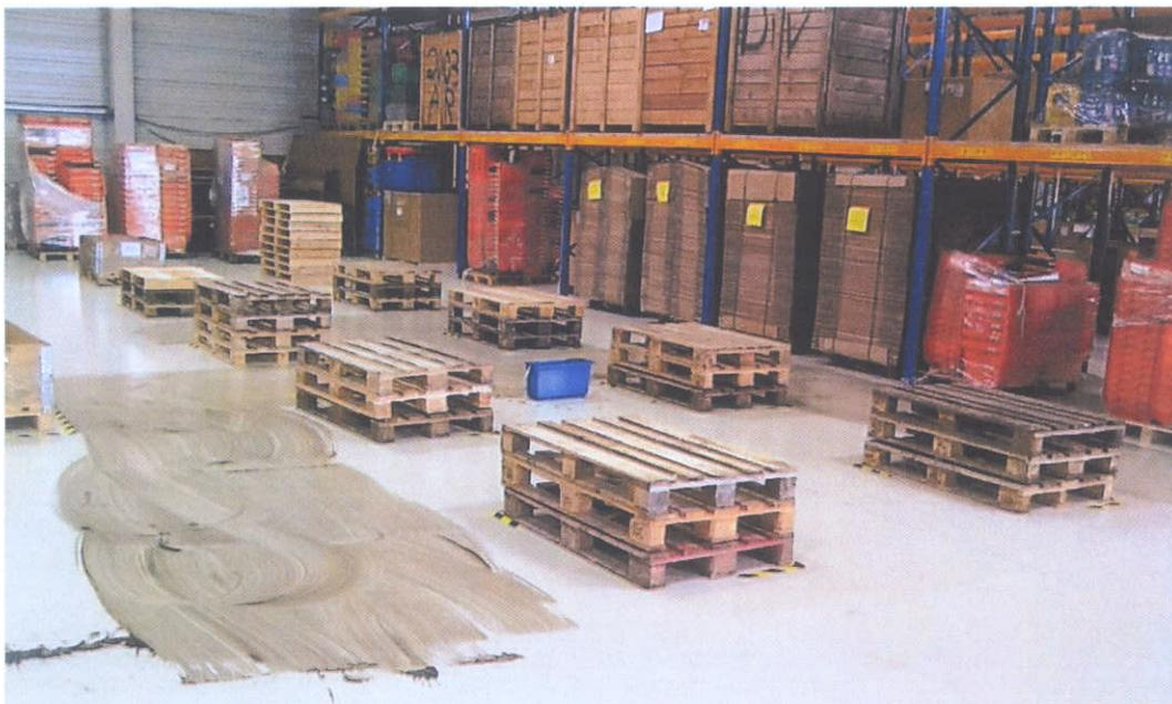
Verschmutzung mit gleichmäßigem Schlammbeleg aus Sand und Mutterboden
